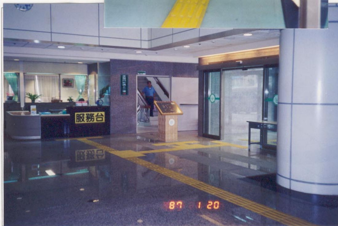
照片 7-4 省立台中醫院觸摸地圖及服務台相隣，不宜再鋪設導盲磚，鋪設導盲磚時應避免過多轉折，使視障者迷失方向。
