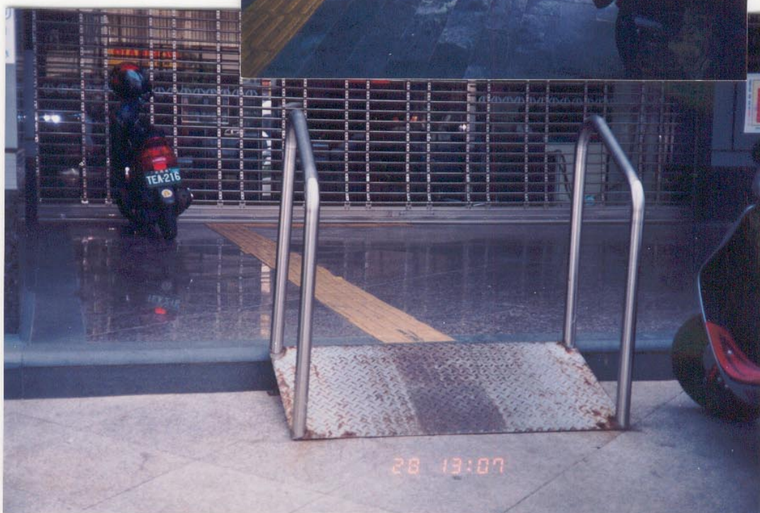
照片 7-24 台中市台中港路(靠近東海大學)某銀行門前之鐵板斜坡，雖亦解決了高低差問題，但造成醜陋的街景。
