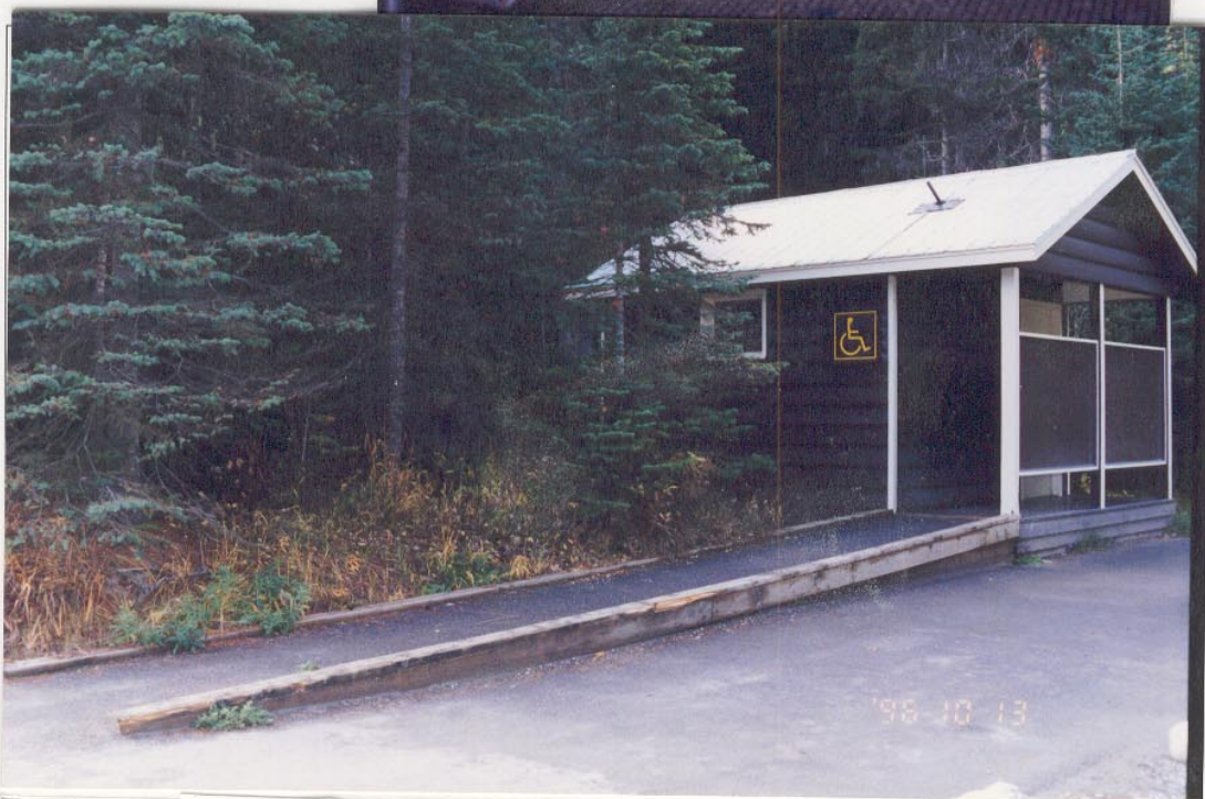
照片 7-61 加拿大洛磯山脈國家公園廁所外面之標示和斜坡道
