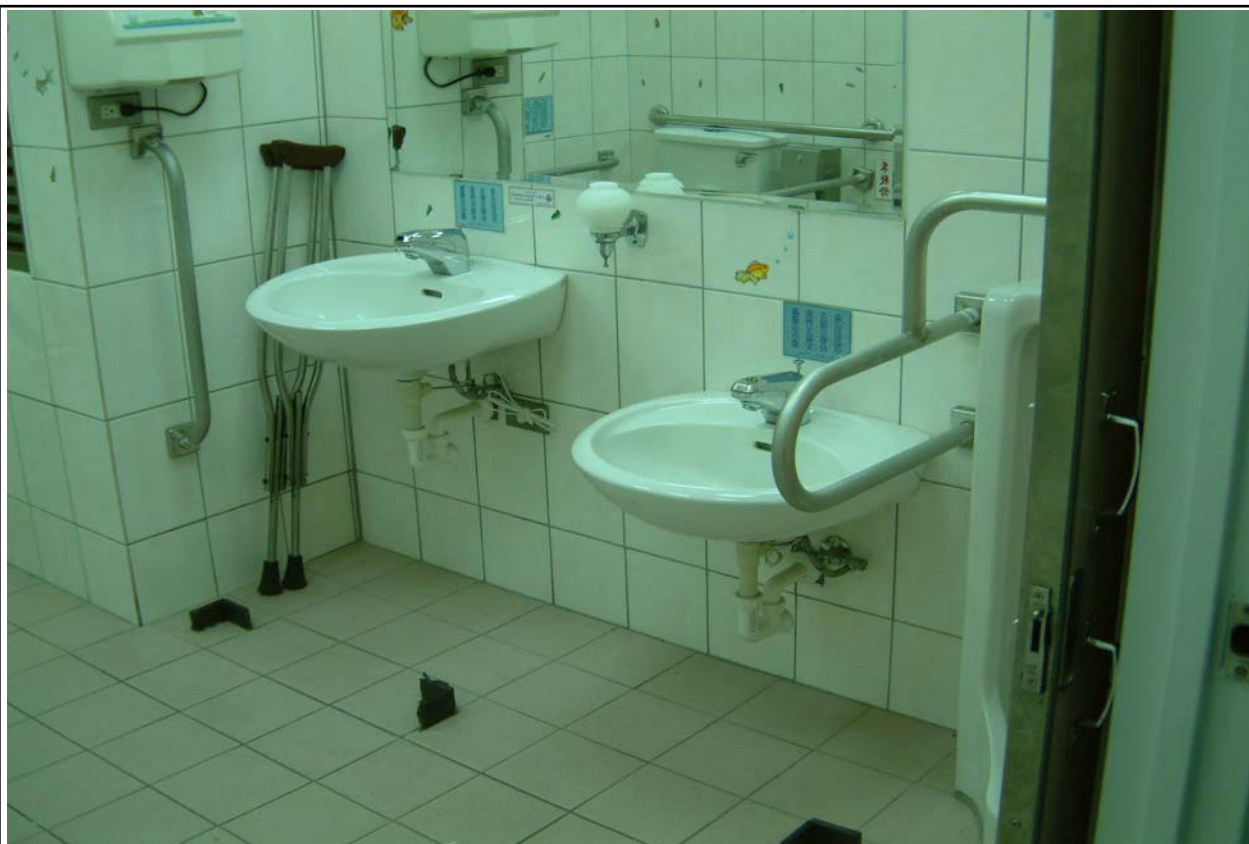
盥洗台的下方淨空間充足，側移坐者方便使用
