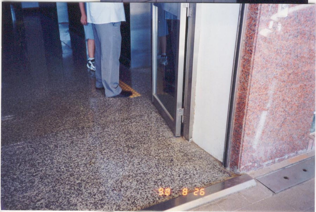
照片 7-63 門檻高於2公分以上輪椅就無法進入應設斜坡道
